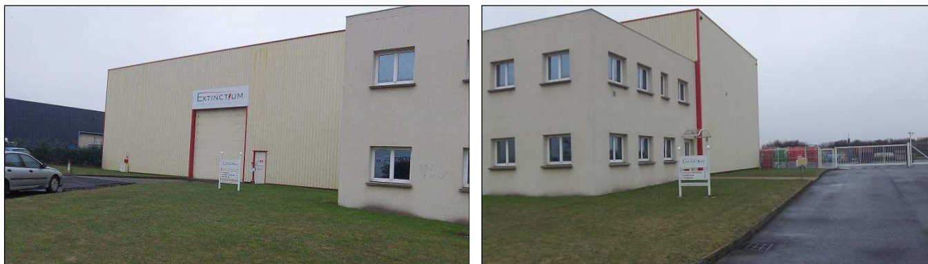
Façade du bâtiment
